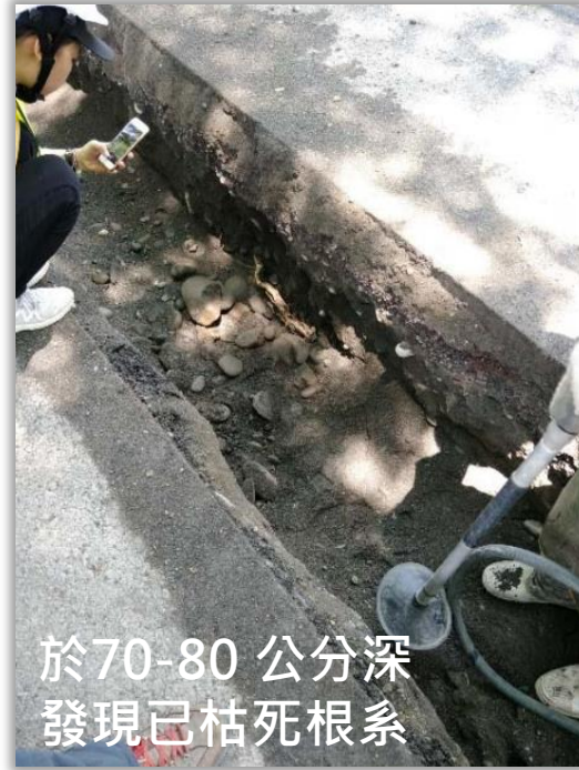
挖掘溝槽 (路緣石外側 1 公尺位置)
