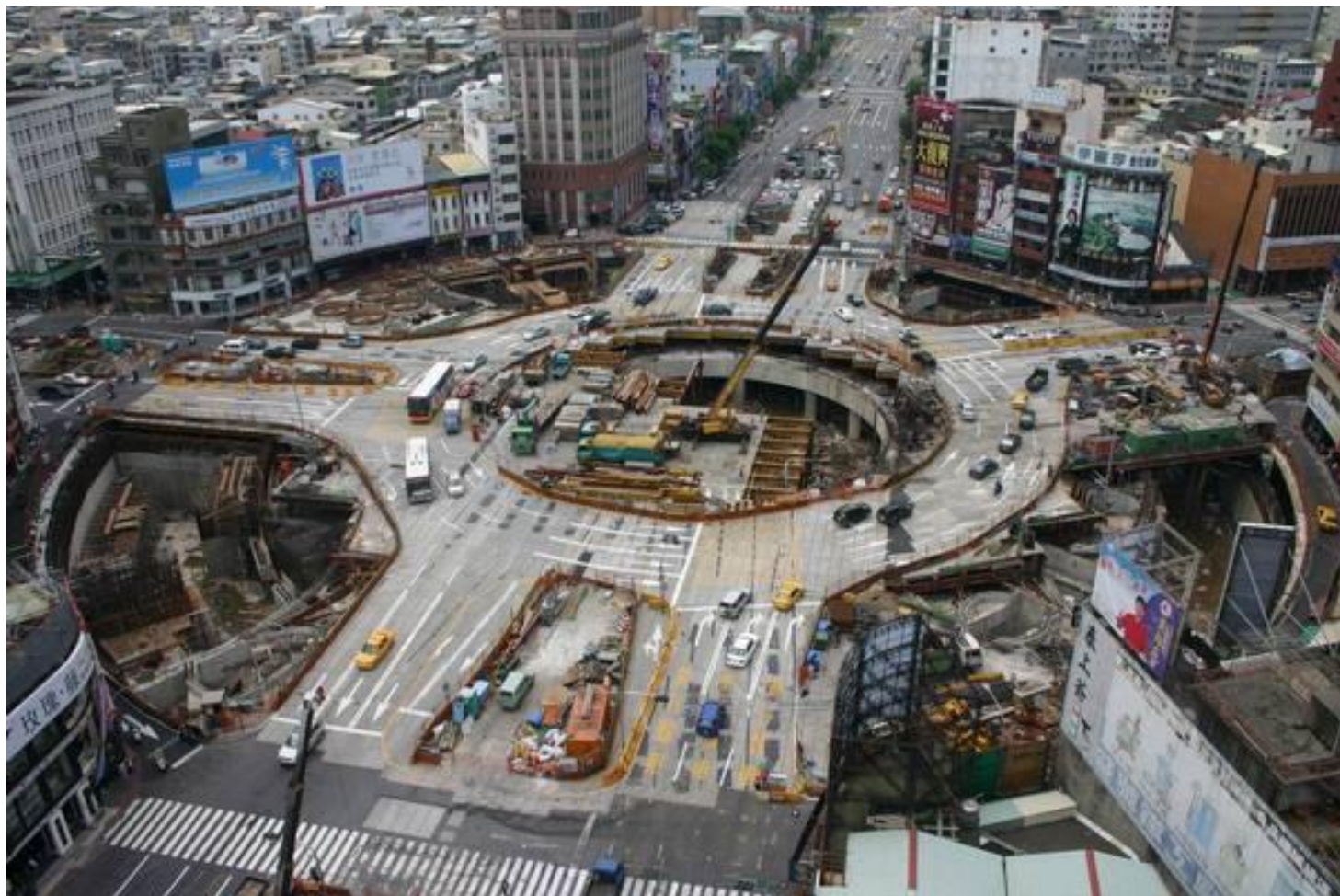
美麗島站施工照片
