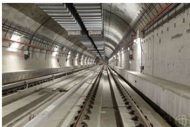
地下段基座式軌道
