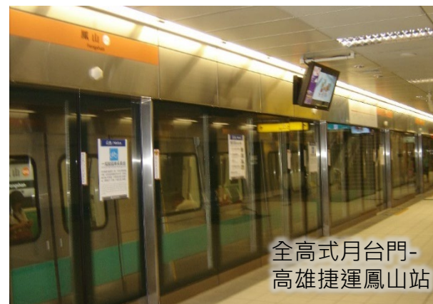
半高式月台門- 高雄捷運大寮站
