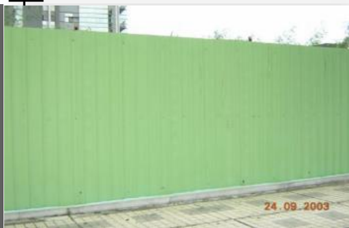
設置施工圍籬
